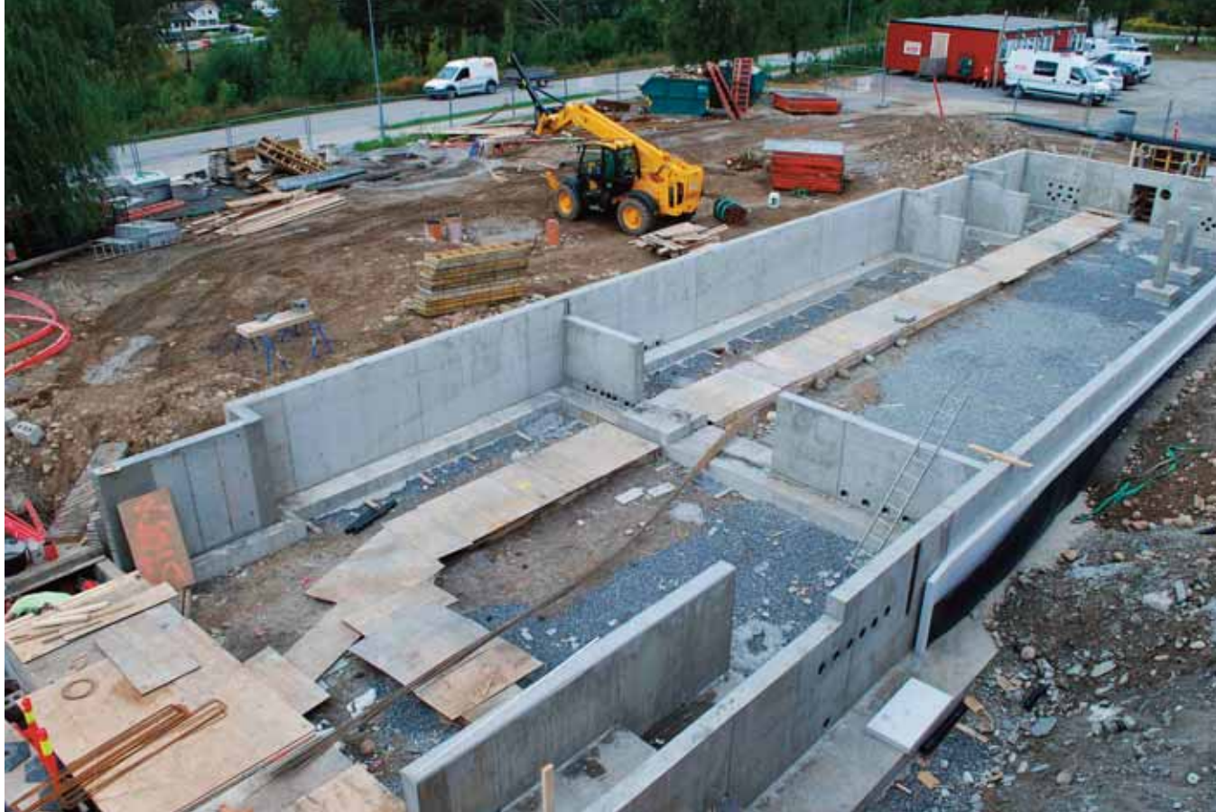
I RUTE: Arbeidene med det nye administrasjonsbygget i Lienveien er i rute.
