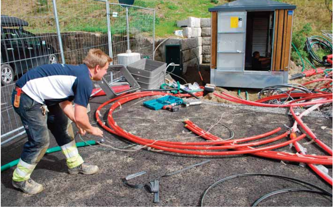
NY NETTSTASJON: Notodden Energi har lagt nytt kabelnett i torvområdet og satt opp ny nettstasjon på lasaretttomta. Her er det Hans Olav Kaasa og Øyvind Lie (under t.h.) som er i full gang med å klargjøre den nye nettstasjonen.
