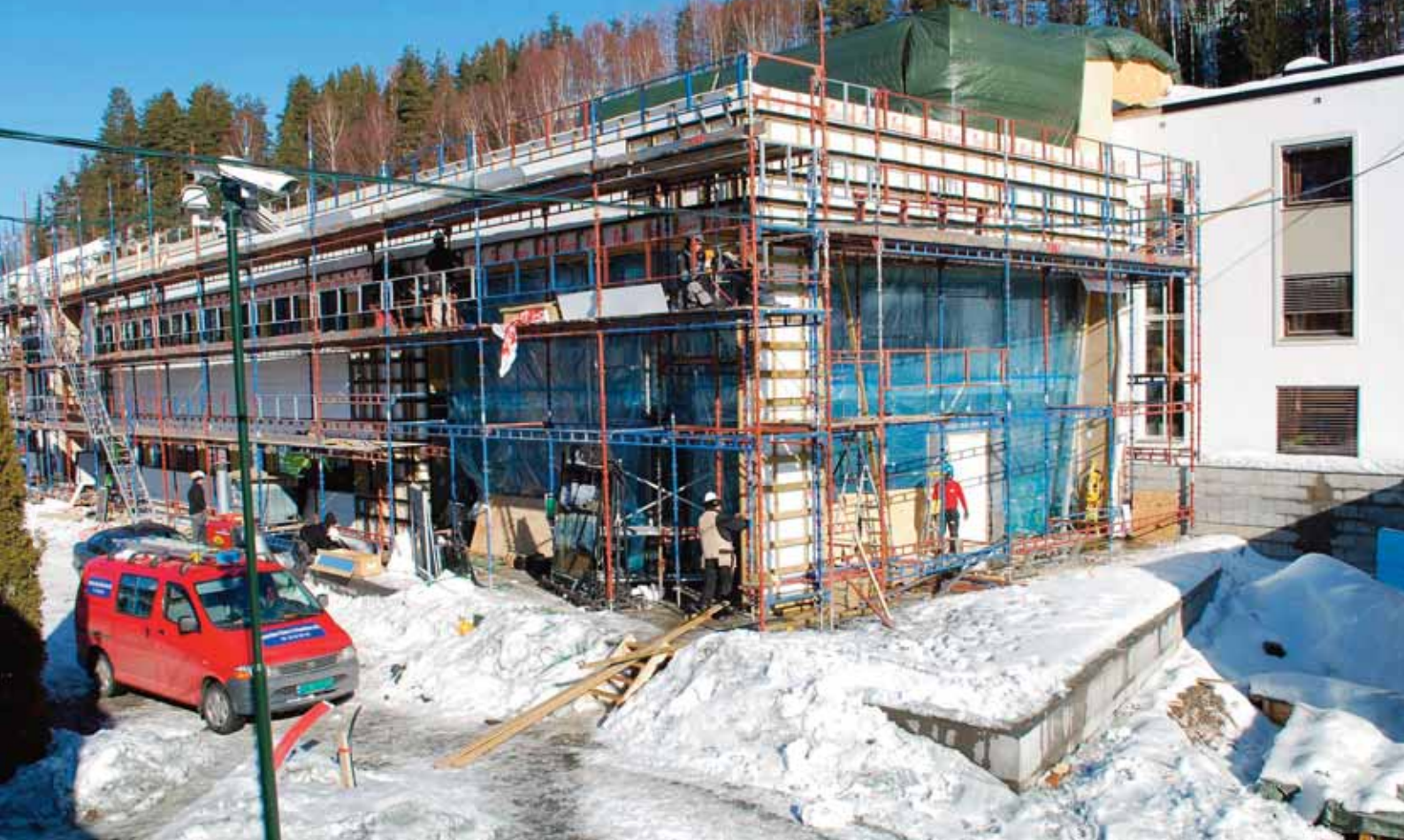
TAR FORM: Det nye administrasjonsbygget til Notodden Energi i Lienveien begynner for alvor å ta form.
