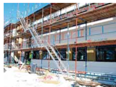
FERDIG I JUNI: Hvis alt går etter planen i innspurten vil nybygget være klart for innflytting i løpet av juni.
